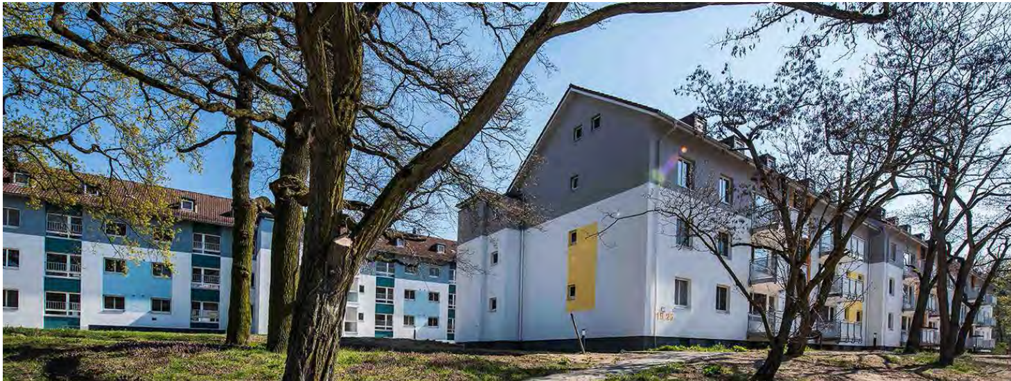
Foto: bauverein AG
